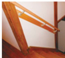
■手すりの設置
