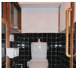
■手すりの設置
